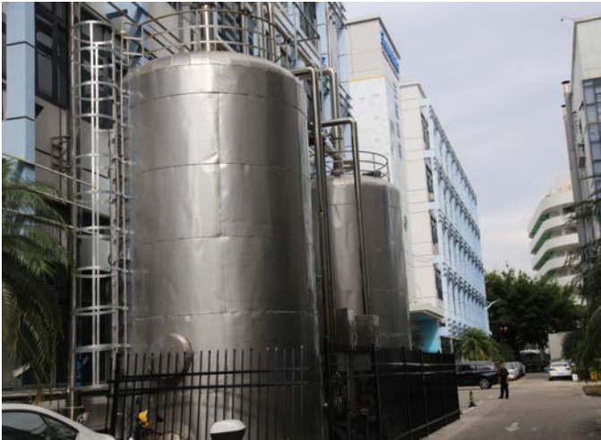
图 11.4 削峰填谷储能蓄冷
