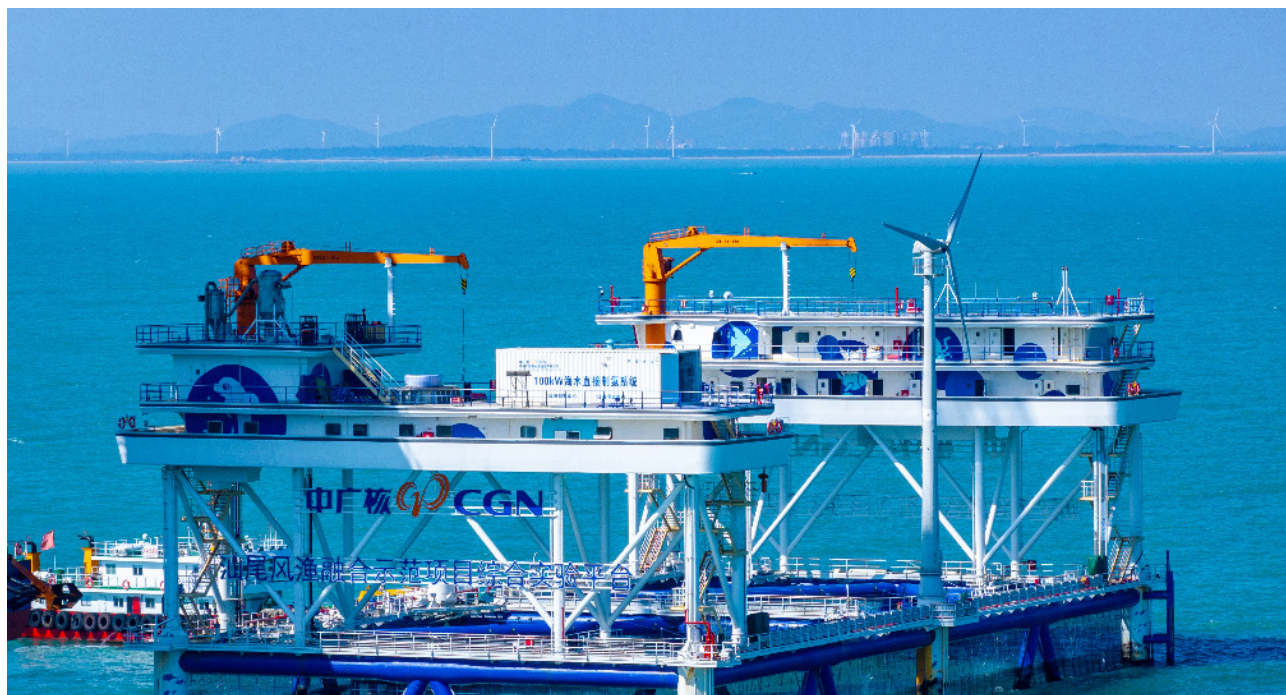
图 1.3-1 中广核 100kW 电解海水制氢示范工程
