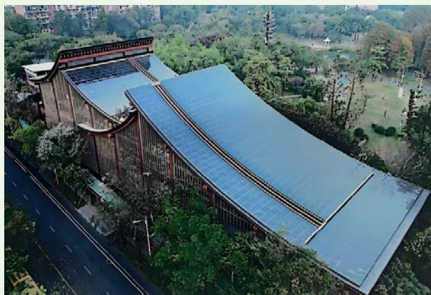
图 1.7-4 深圳四海公园立体停车场 BIPV 项目
