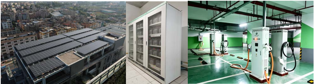
图 9.2 未来大厦屋顶太阳能光伏阵列（左）；储能系统（中）；电动车有序放电（右）
