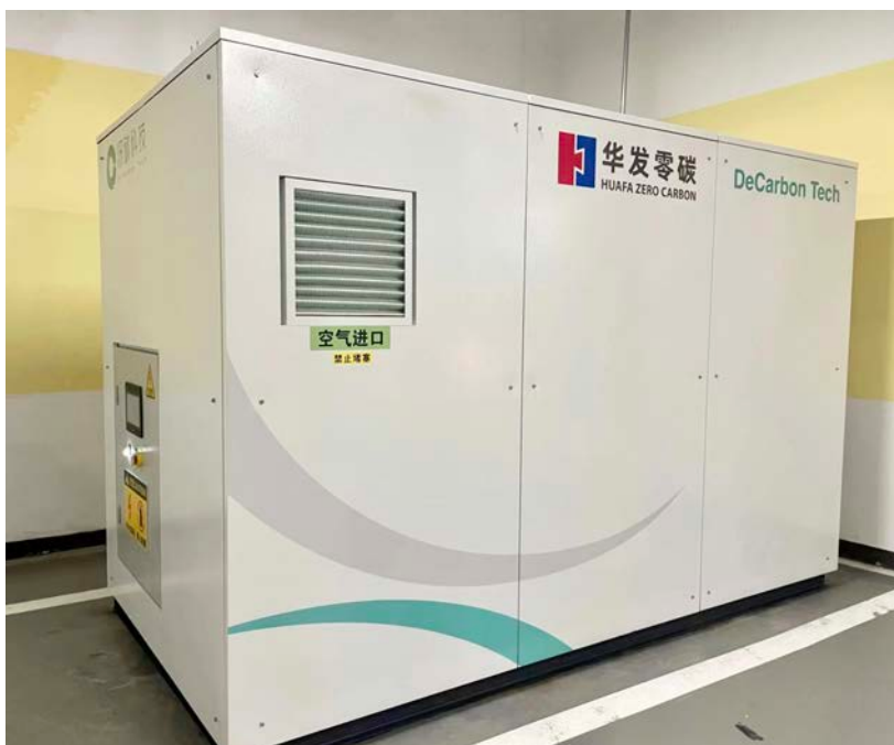
图 8.1-1 直接空气碳捕集设施
