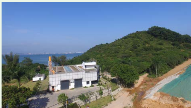
图 6.6 大鹏新区厨余垃圾收运处理服务项目
