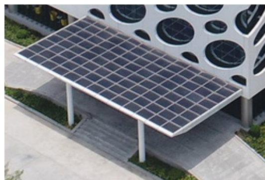
(b) BIPV 雨棚光伏系统
