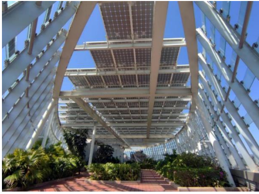
(c) BAPV 屋顶光伏系统
