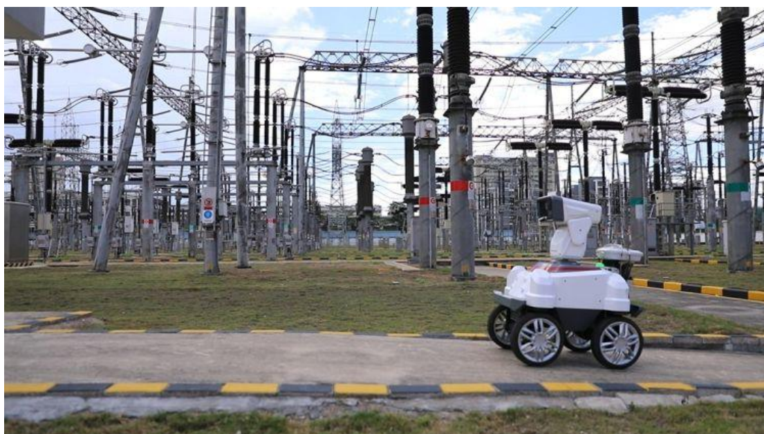
图 21 变电站 5G 巡检机器人
